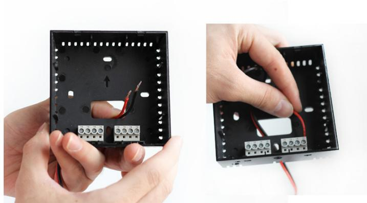
Con ayuda de un destornillador coloque los cables en posición ADECUADA, atendiendo a las marcas que verá dentro de la carcasa.
